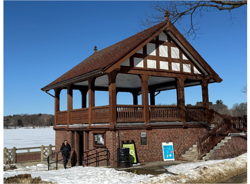
Bandstand: 1 story + open air pavilion
