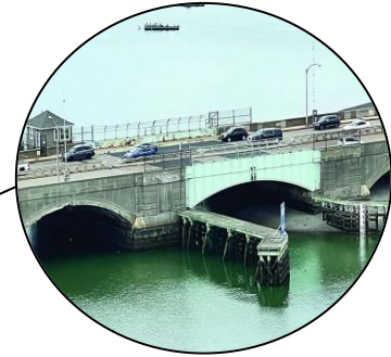
Beades Bridge Prujetu di MassDOT na Fazi di Design
