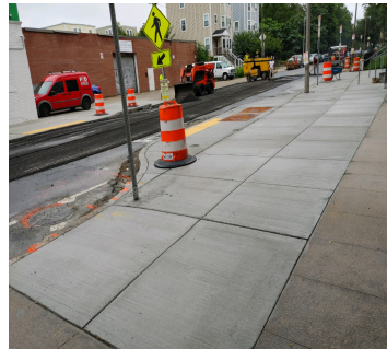
Via Hè Được Sửa Chữa
