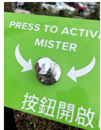
Ejemplo de válvula de agua dosificadora. Este tipo de válvula está configurada para dispensar agua durante un período de tiempo definido, lo que significa que no hay riesgo de que quede agua abierta.
