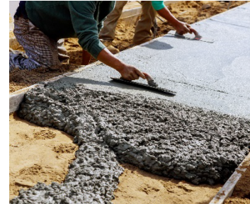
Sửa chữa vỉa hè
