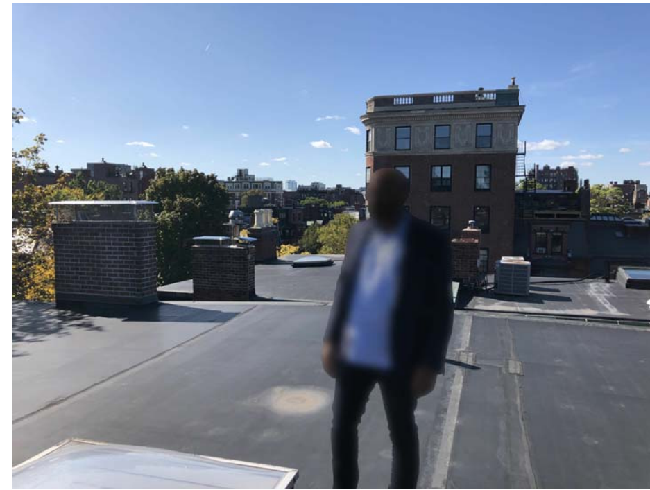
(D) Existing Condition - Roof looking West
