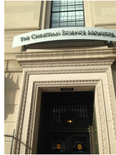
TENANT ENTRY - EXISTING EXTERIOR
