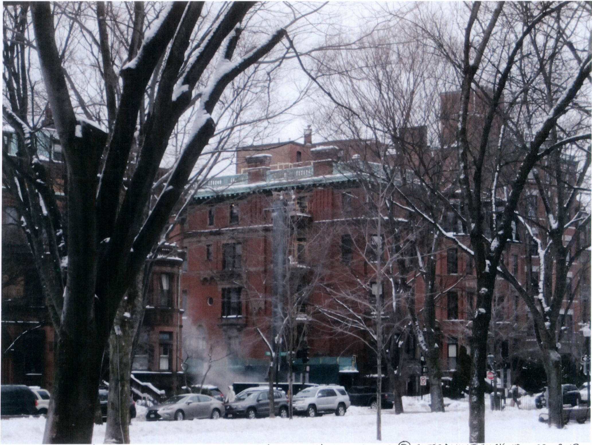
284 COMM. AVE. - PHOTO (D) MEZZANINE MOCK UP 02.13.17
